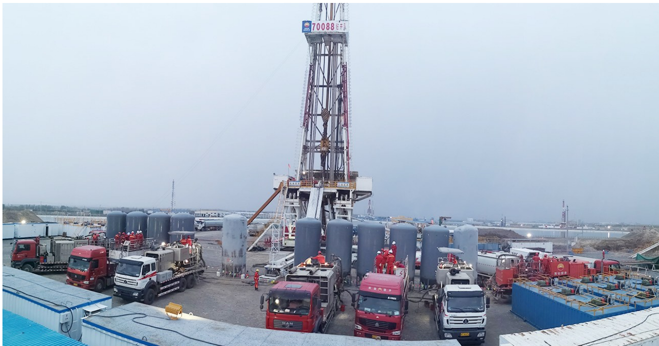
呼图壁储气库固井施工现场。
